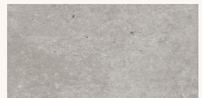
Balkone / Loggias 2.OG-7.OG Hartbeton gestrichen
