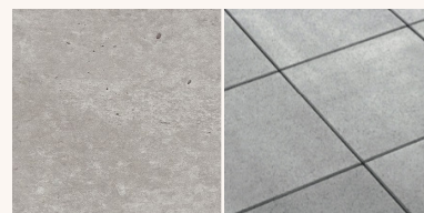
Balkone / Loggias 2.OG-7.OG Hartbeton gestrichen Balkone 1.OG Gehwegplatten Beton 60x60 cm
